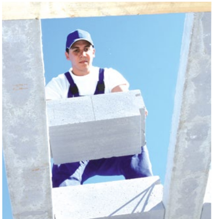
Födémbéleléstestek elhelyezése
